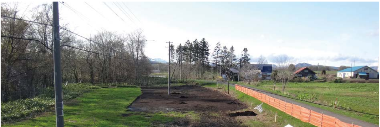
14 調査区全景（南から北、奥の電柱付近が現沢頭）
