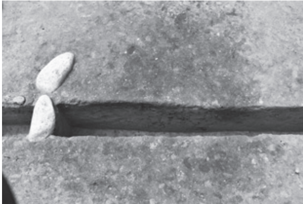
1 H-4 HF-1 断面 (東から)
