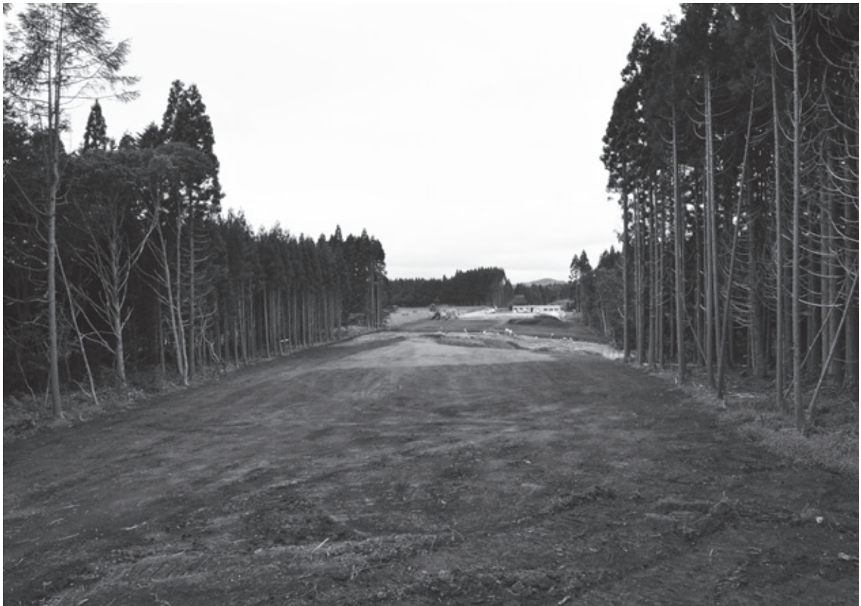
2 調査終了(東から)
