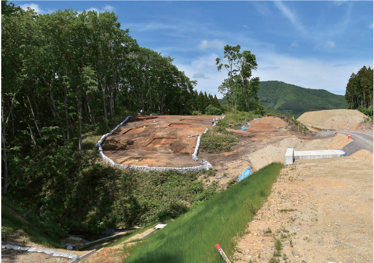
2-1 南側から見た調査区 (SW →)
