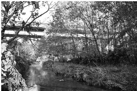
3 調査範囲2-④農道橋付近
