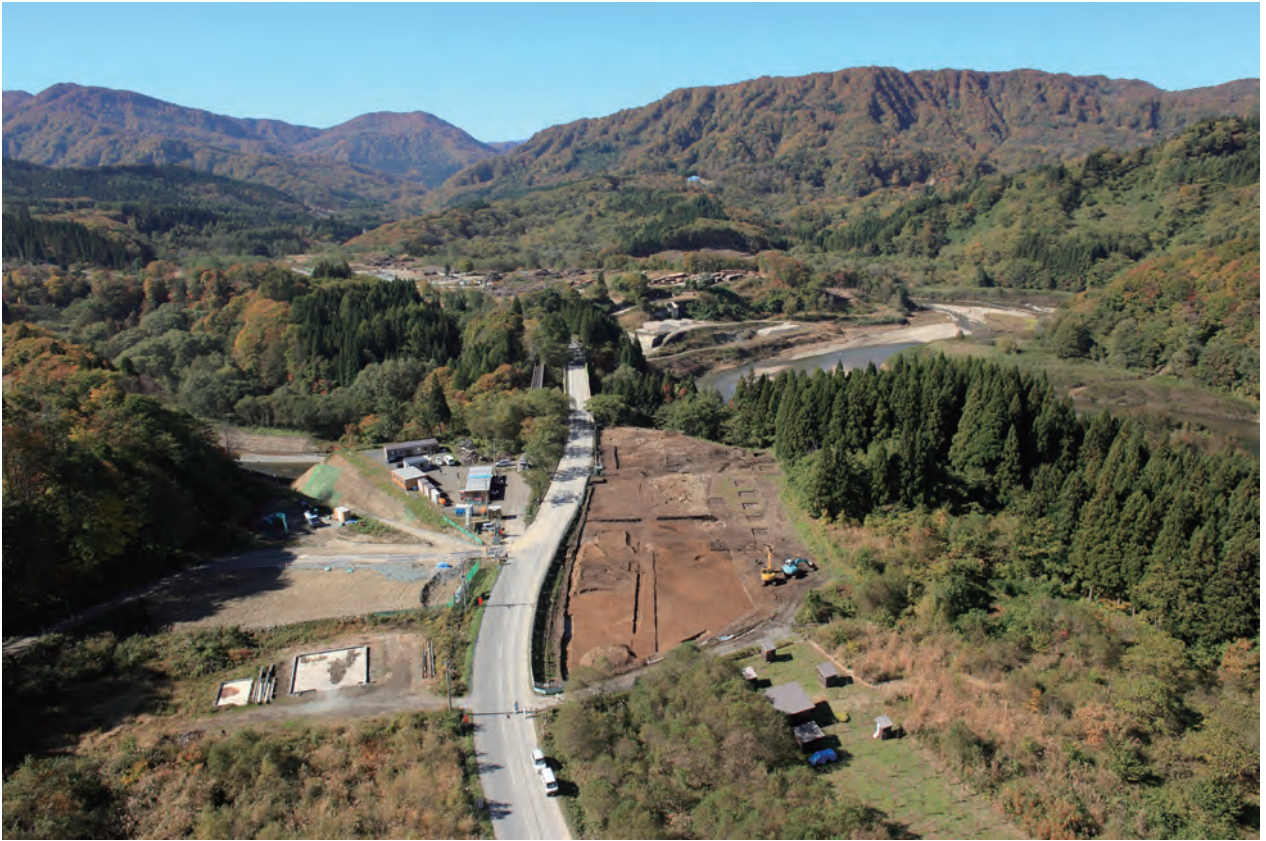
1. 調査区全景 2011年（東から）
