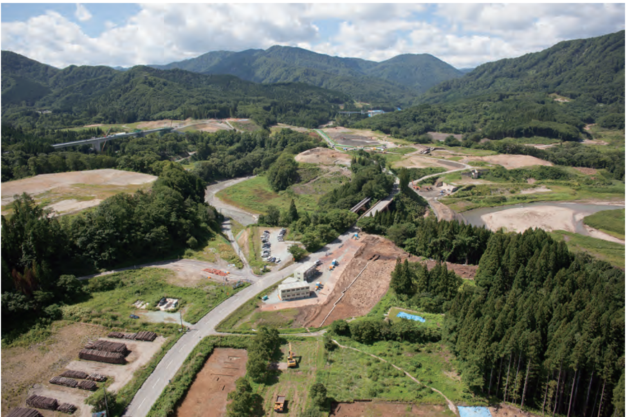
2. 調査区全景 2013年（東から）
