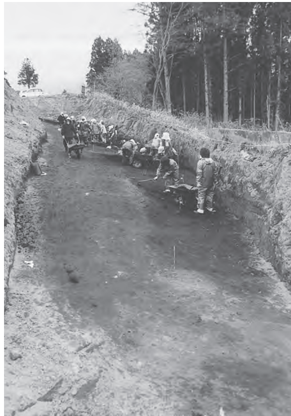
粗掘作業風景 (W→)
