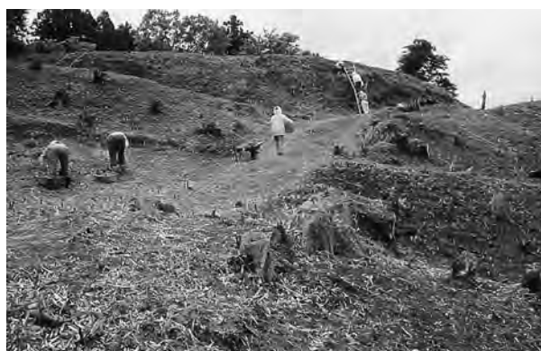
刈り払い作業状況
