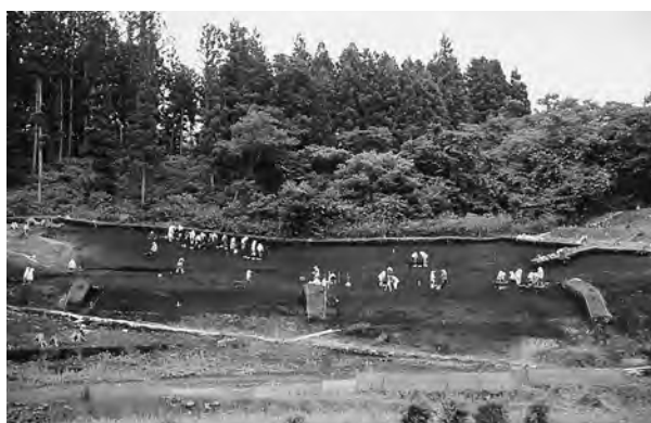
東斜面部検出作業状況
