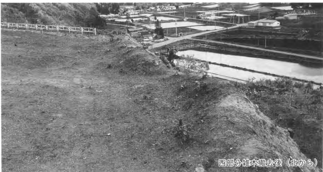
写真12 第1号土塁北側現況
