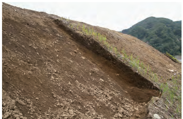
北斜面 土層B-B'(南東から)
