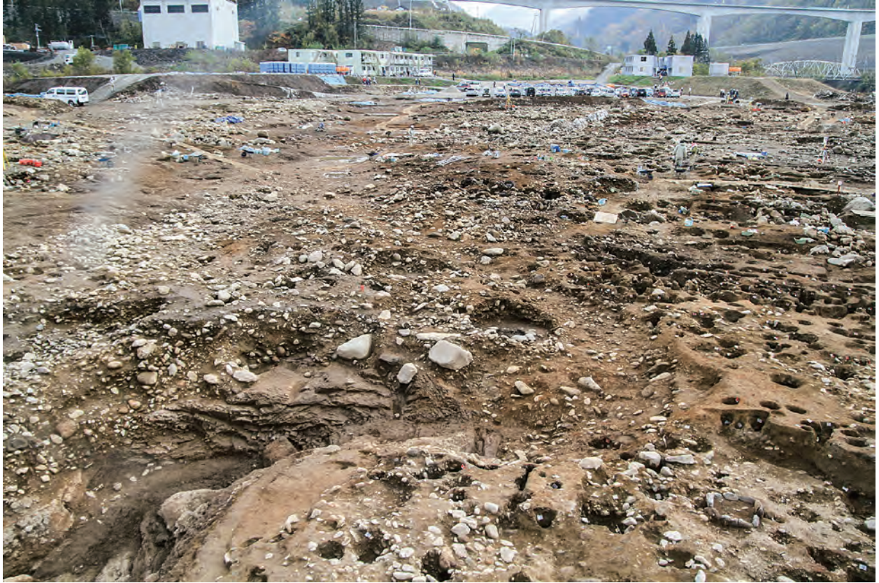
沢1・沢2完掘状況(ⅩA-87グリッド付近から南)
