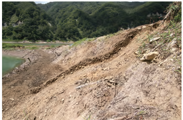
西斜面 土層(南東から)
