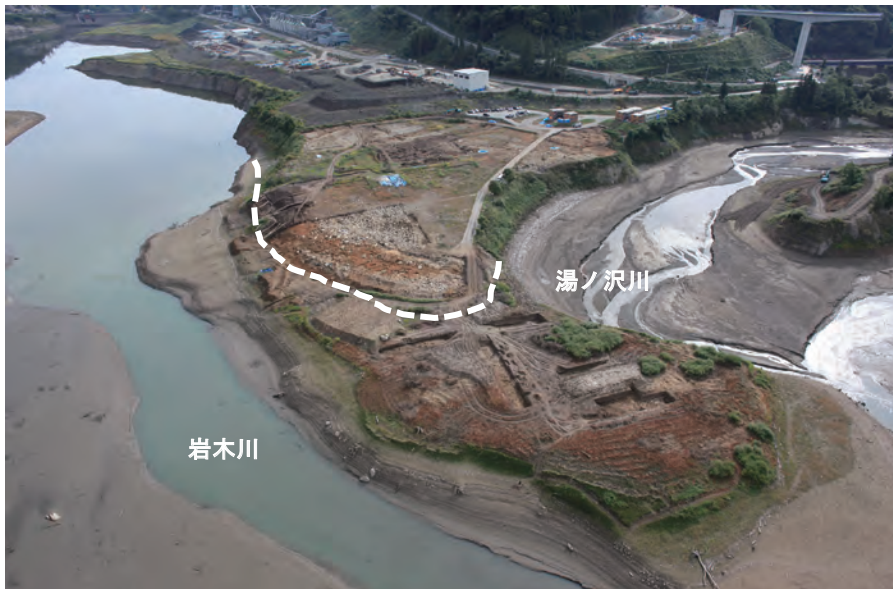
1 北東方向上空から ※点線外側が低い段丘面
