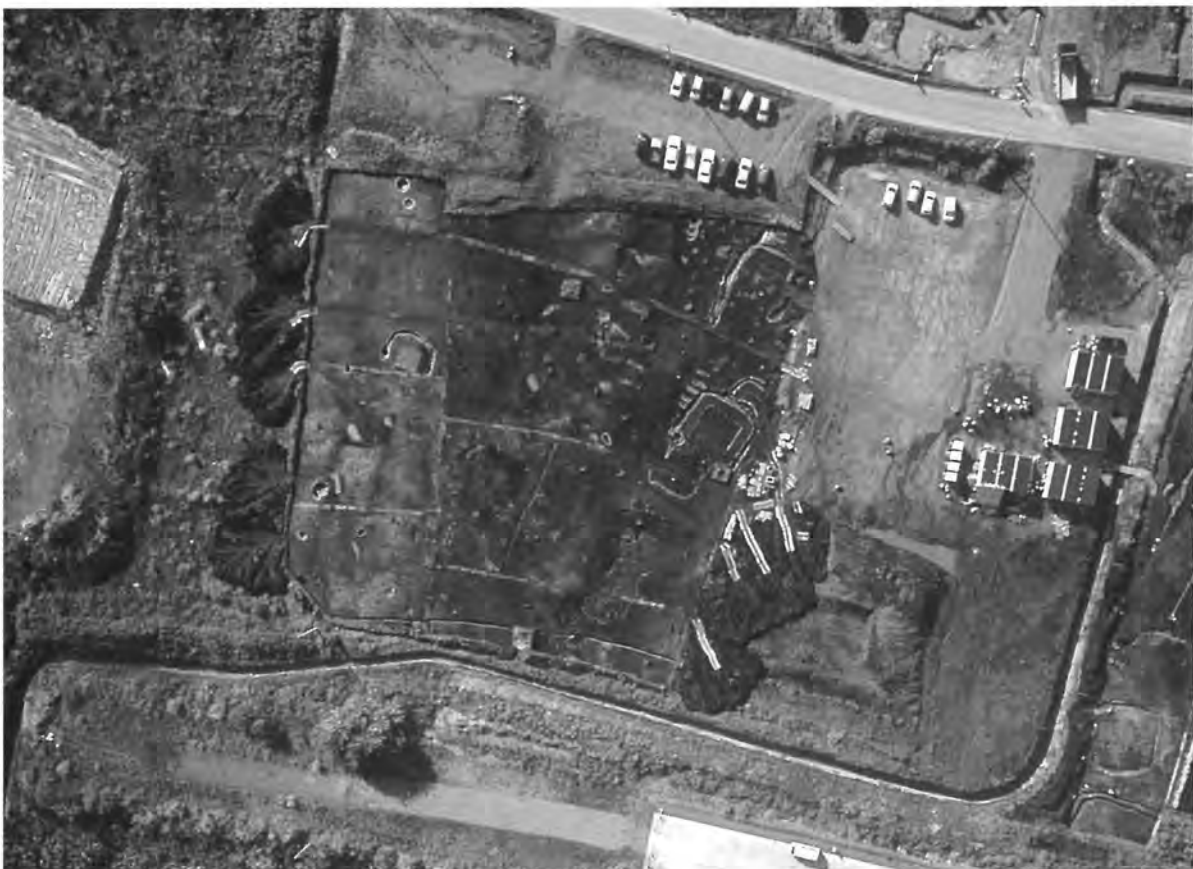
C区全景 上空から
