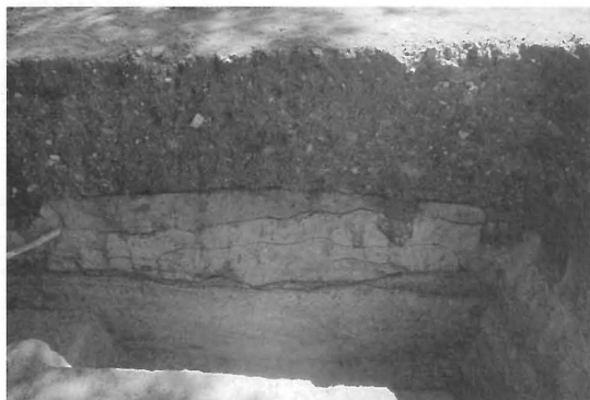
B区第1トレンチ断面
