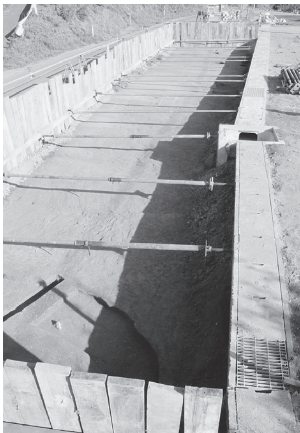
I A～I I-103～107 グリット付近完掘（北西から）
