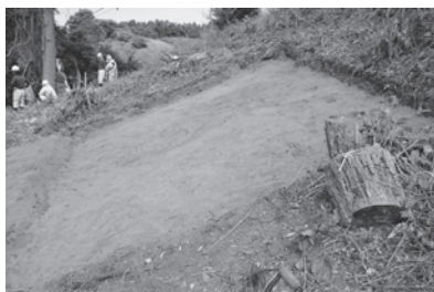
2 トレンチ 完掘 (南から)
