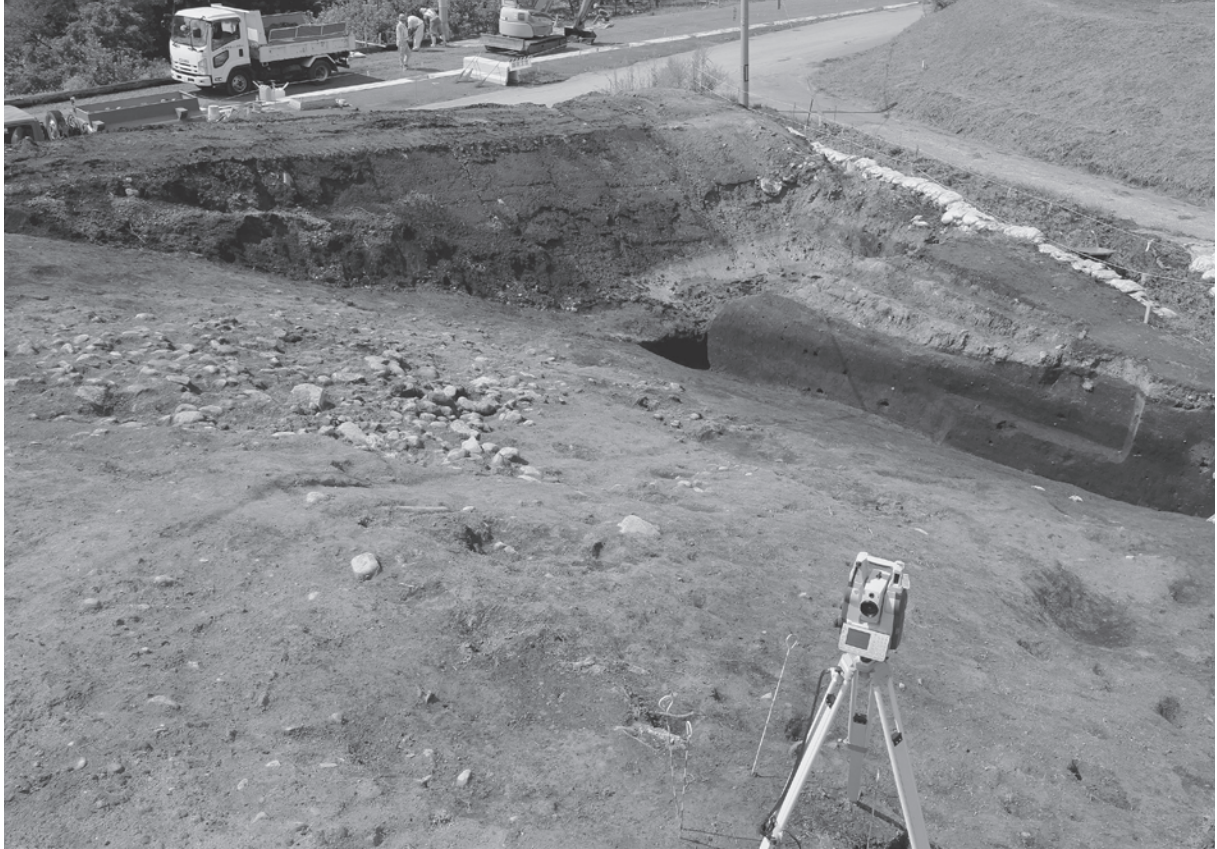
沢 完掘 [ I 0 ~ II A-129 ~ 134 グリッド付近 ] (北東から)
