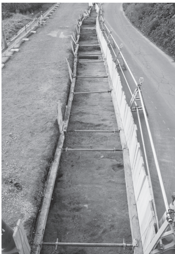
II F～II K-135～143 グリット付近完掘（南東から）
