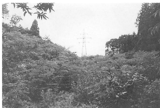
既設鉄塔 (斜面下→)
