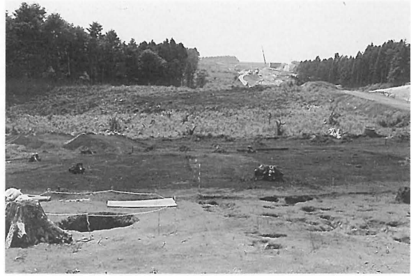
5. 縄文集落区域近景（南から）
