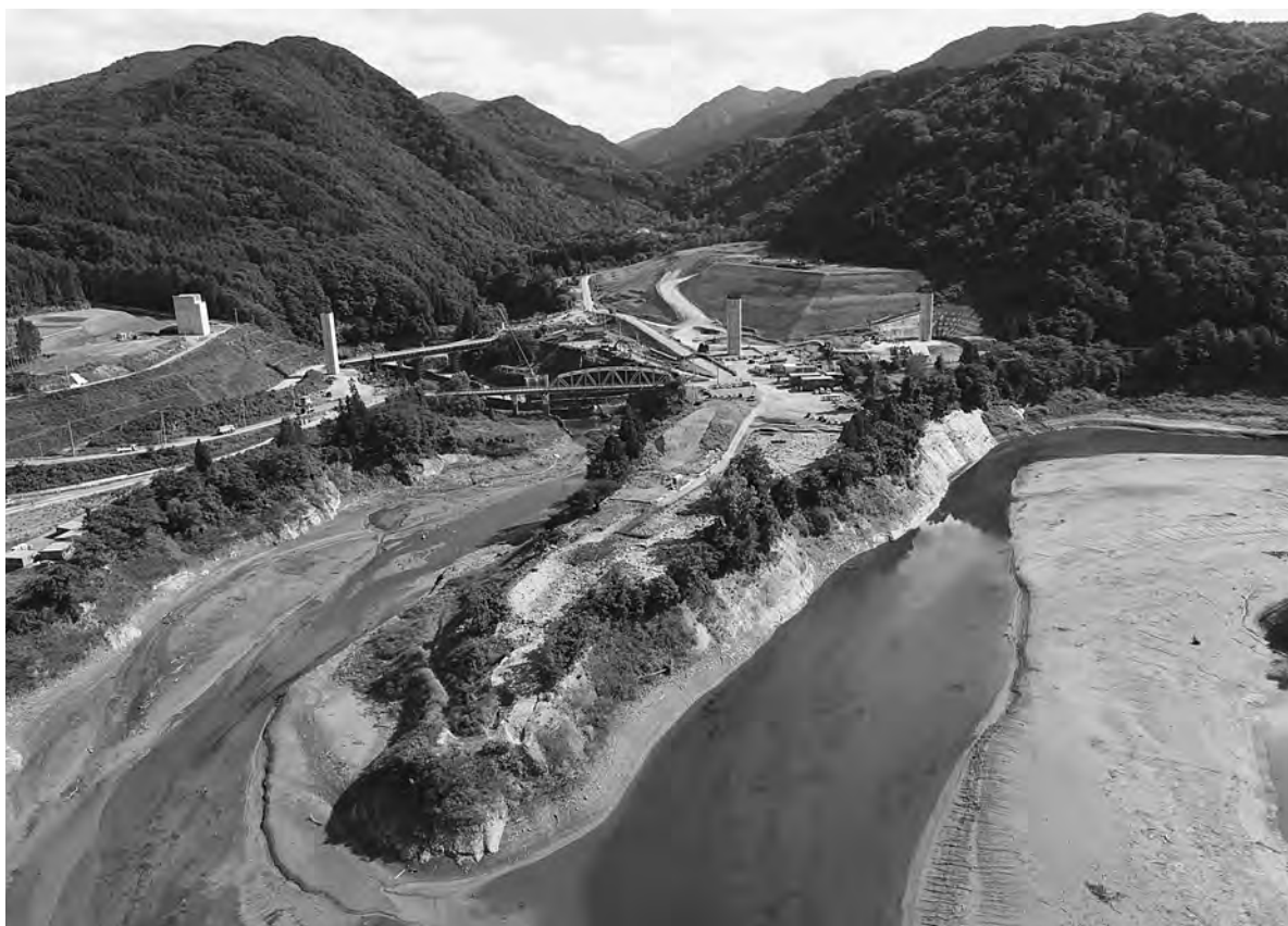
北西から（岩木川と湯ノ沢川の合流点）
