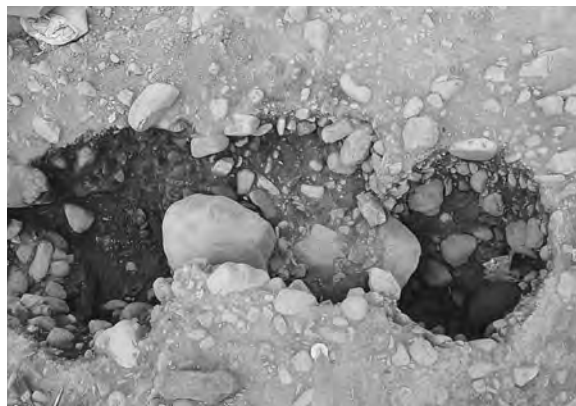
SB03 柱 2・5 ほか完掘 (南から)
