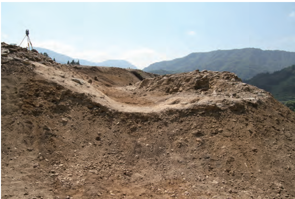
7 クラック地区完掘(2) 東→
