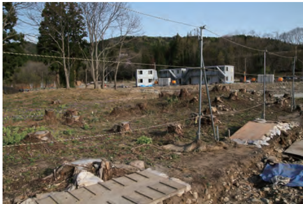
4 盛土地区 北西→
