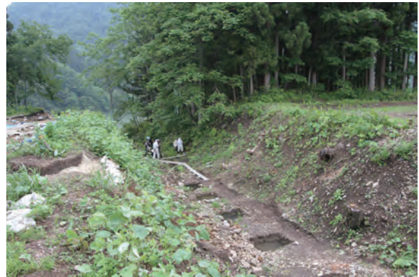
4 沢 (旧村道) 調査状況
