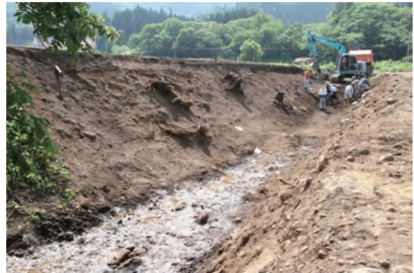
6 沢 (旧村道) 表土除去直後 北西→
