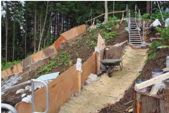
1 調査風景 作業環境 西→
