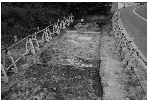
LNo. 7+8. 8付近完掘状況
