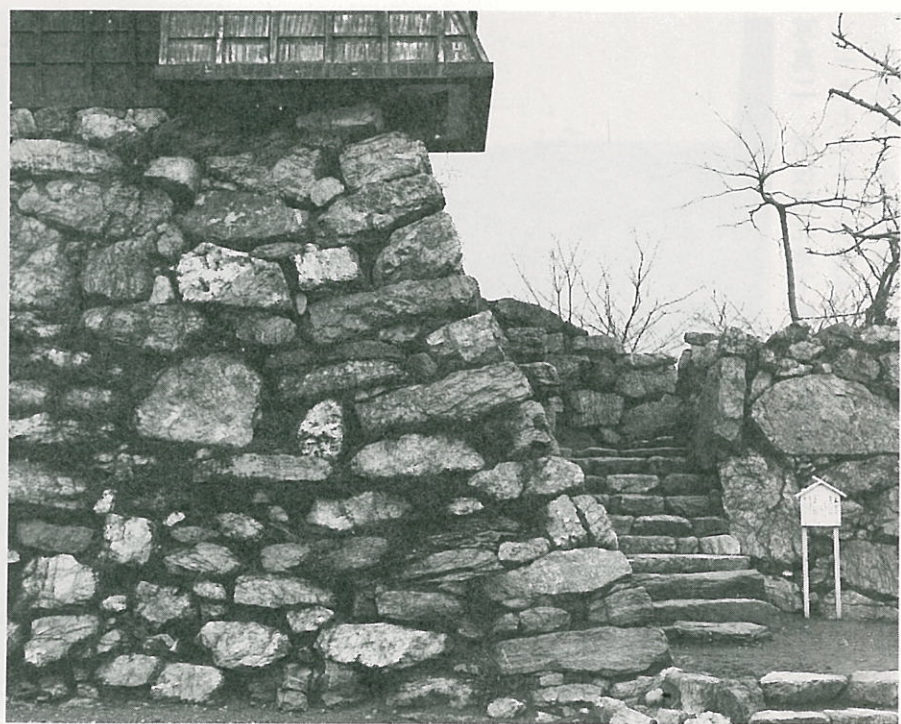
写真四 現存する天守台石垣と東付櫓の石垣（部分） 一九六〇（昭和三五）年一月に撮影されたものです。 石垣角の算木積みのようにがよくわかります。
