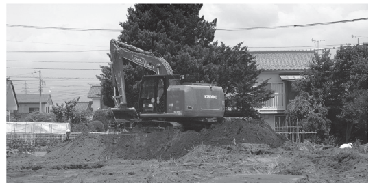
重機による表土除去作業
