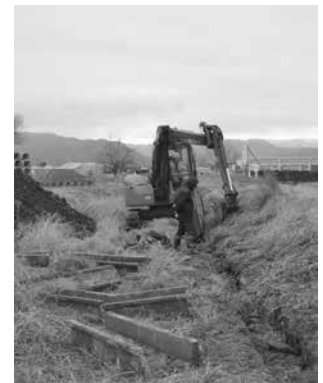
御嶽遺跡 3 掘削状況
