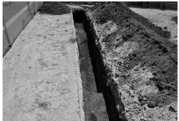
遺構掘り下げ状況
