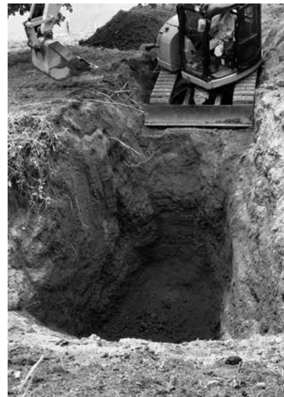
塚部分掘削状況
