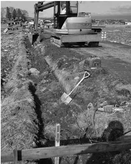
久禰添遺跡10 掘削状況
