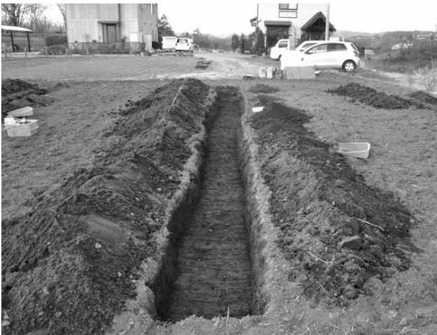
西側調査区 掘削状況
