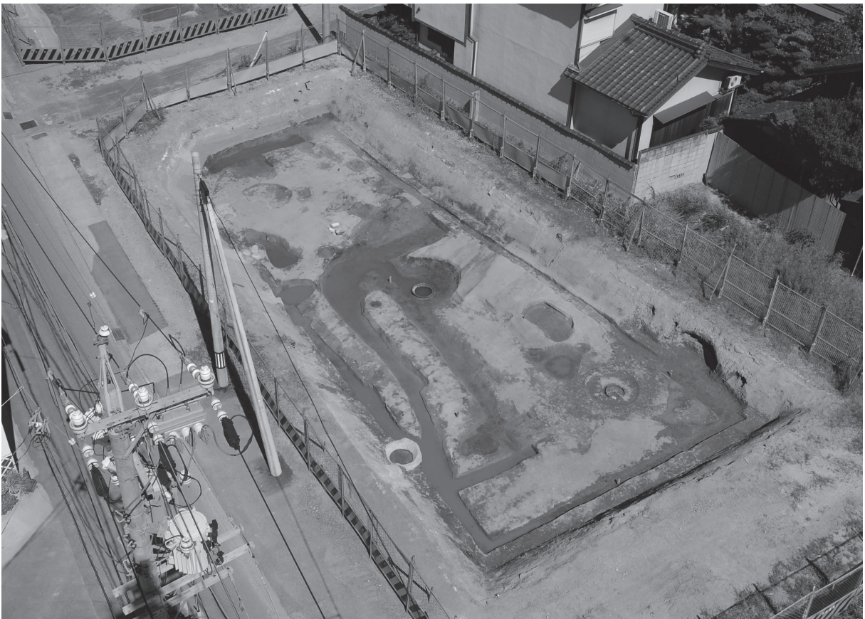
23 2工区全景（南西より）
