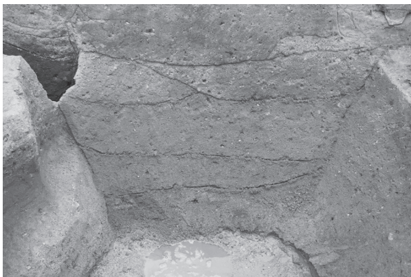
74 SD4075 断面 (西より)
