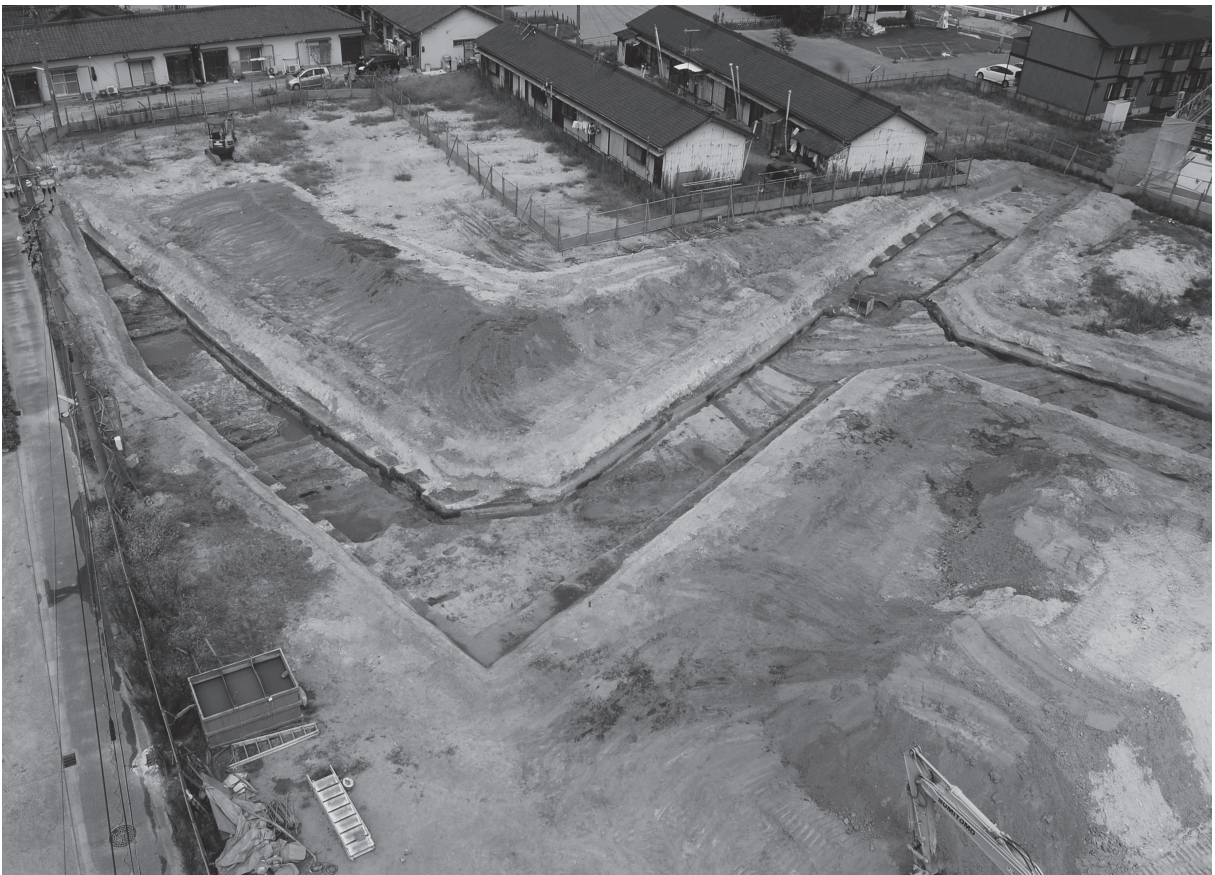
48 3工区全景②（南東より）
