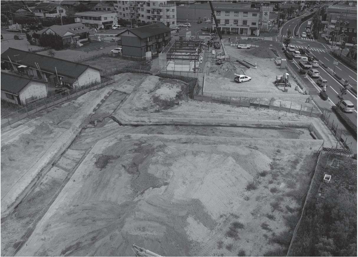
47 3工区全景①（南東より）
