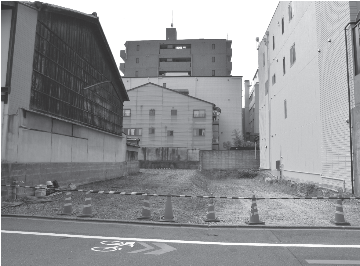
1. 調査前状況（北から）
