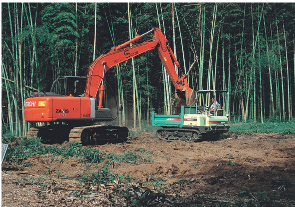
重機による表土除去
