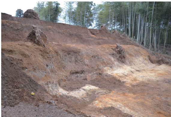
曲輪Ⅰ・Ⅱ間斜面表土除去後状況（北から）
