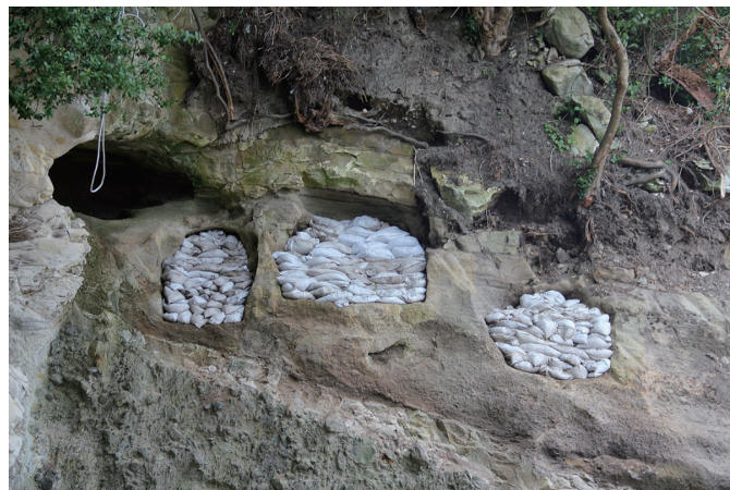
⑧ 1～3号墓保護状況（南東から）
