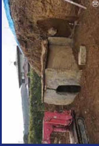
壁石の転倒の原因となっていた壁石と天井石の隙間には、埋め石を行いました⑩。
