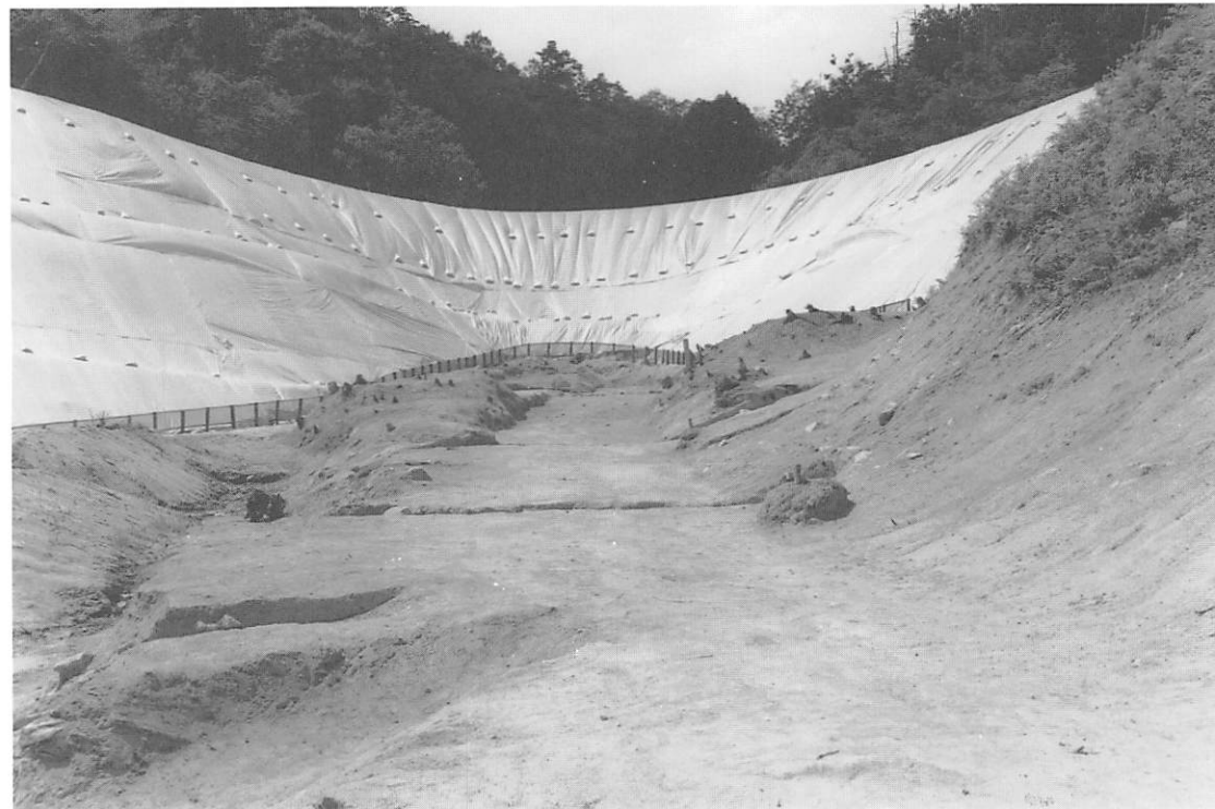
c 同上検出状況（東から）
