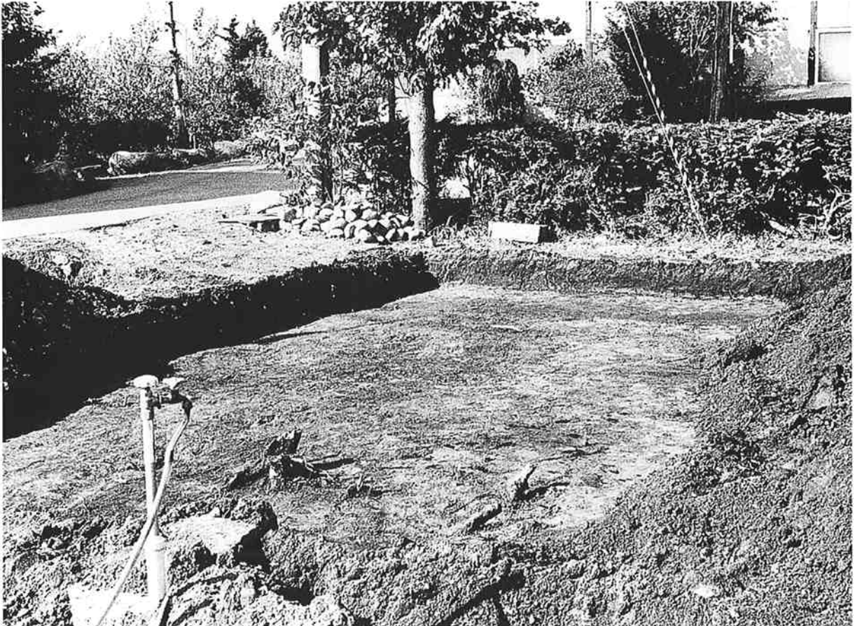
志波城跡第84次調査区全景
