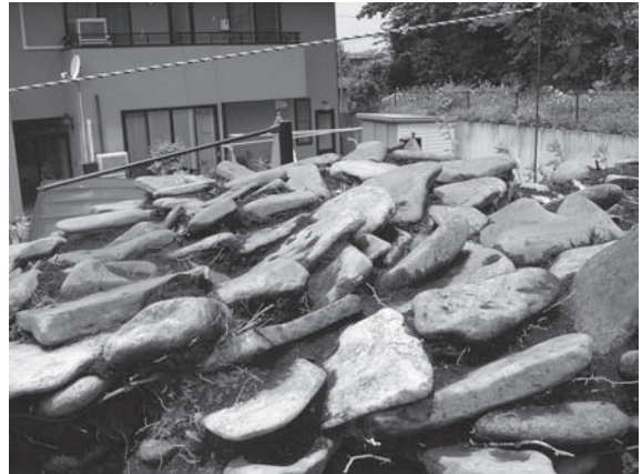
礫詰み方状況 (L=-0.5m)
