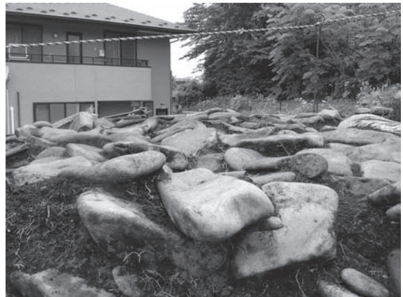
礫詰み方状況 (L=-0.6m)
