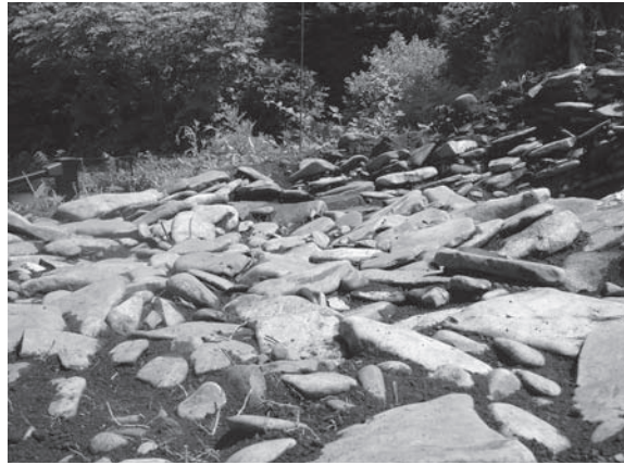
礫詰み方状況 (L=-0.9m)
