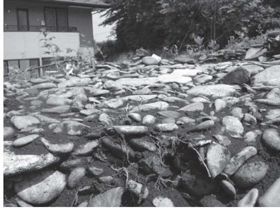
礫詰み方状況 (L=-0.8m)
