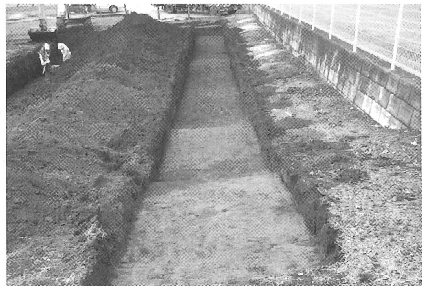
調査トレンチ
