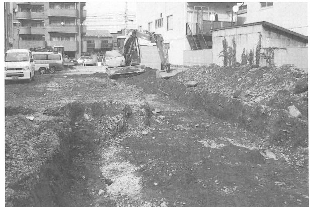
調査区全景（試掘調査状況）
