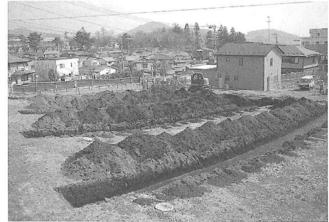
試掘調査の状況
