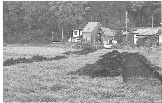
試掘調査の状況
