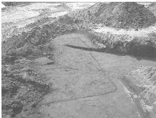
遺構の検出状況
