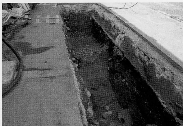
5 B区全景 (南東から)
