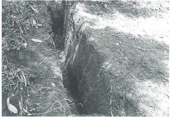
4. トレンチ7 完掘 (南から)
