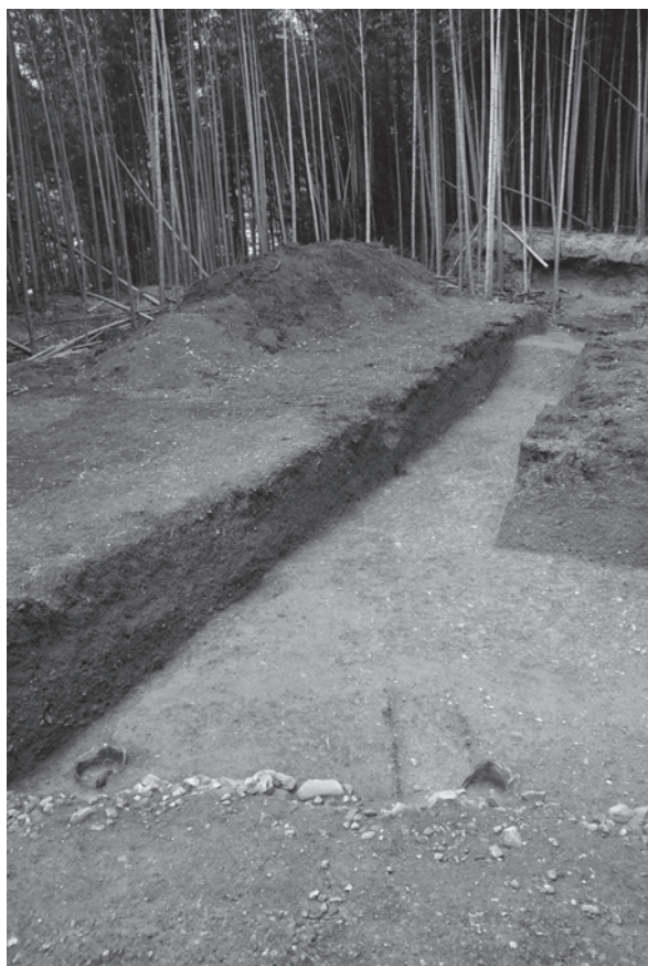
2 1 トレンチ北西拡張部（南西から）
