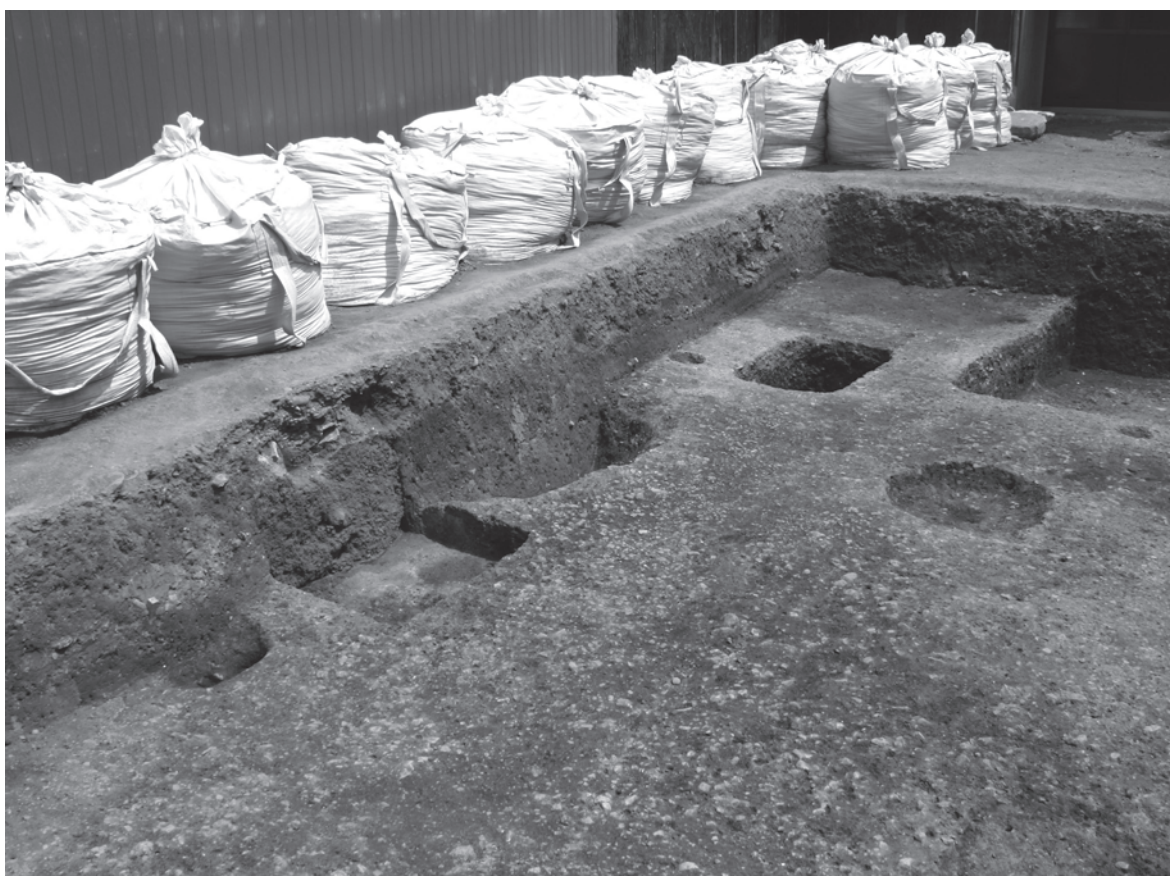
2 第5層上面整地状況（西から）
