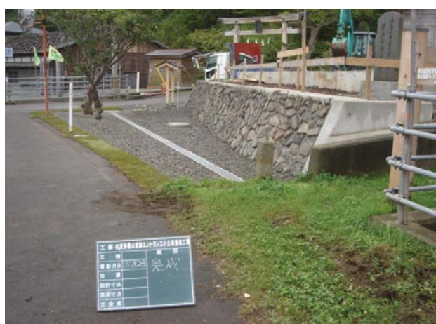
4. 上ノ國八幡宮社務所北側 エントランス石積整備後（北西から）
