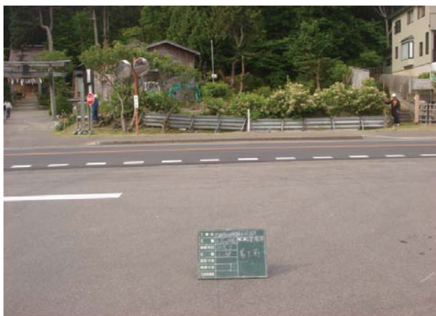
1. 上ノ國八幡宮社務所北側 エントランス石積整備前（北から）
