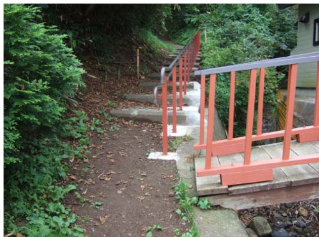
3. 勝山館跡散策路入口 手摺整備後 (北から)
