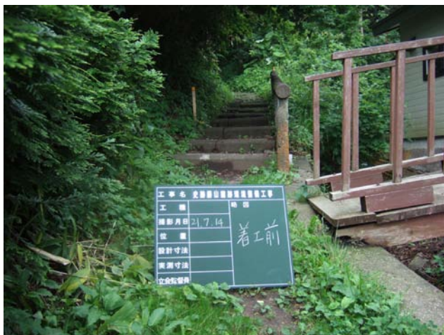
1. 勝山館跡散策路入口 手摺整備前 (北から)
