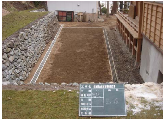
6. 上ノ國八幡宮西側 石積整備後（南から）
