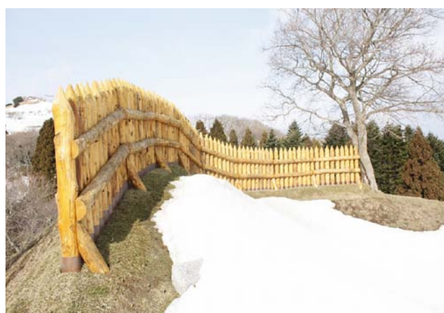
8. 勝山館跡 柵列整備 (東から)
