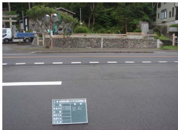
2. 上ノ國八幡宮社務所北側 エントランス石積整備後（北から）
