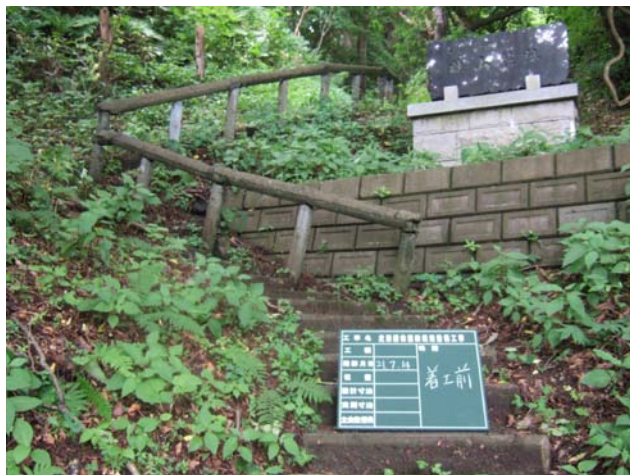
2. 勝山館跡散策路入口 手摺整備前 (北から)
