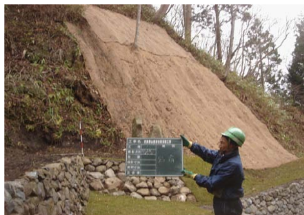
8. 上ノ國八幡宮西側 法面保護整備後（東から）
