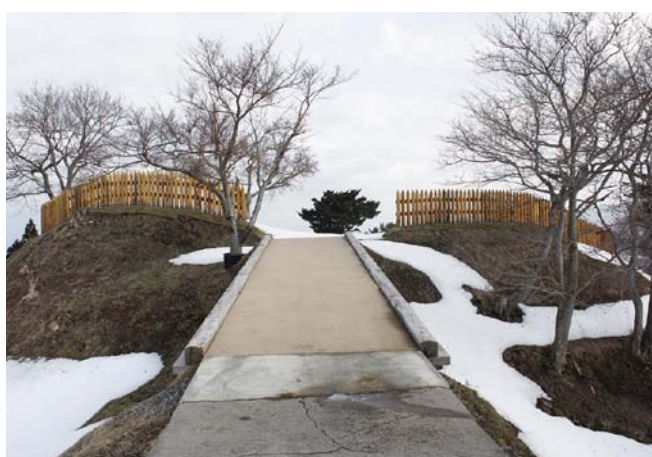
7. 勝山館跡 柵列整備 (南西から)
