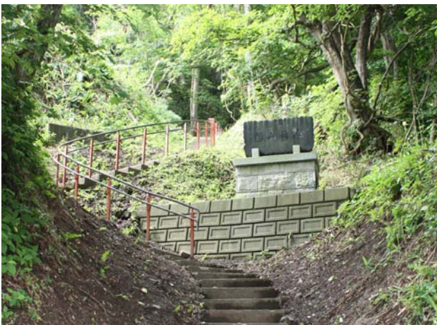
4. 勝山館跡散策路入口 手摺整備後 (北から)
