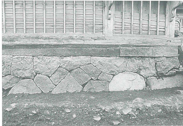
2 旧笹浪家住宅主屋正面石垣（西側部分）
