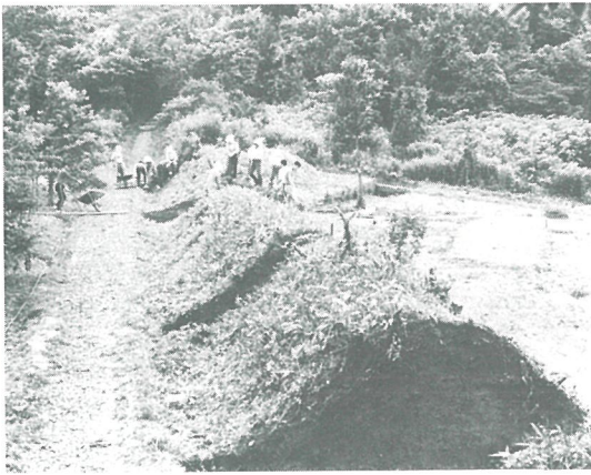
作業風景 1 (土堤部)
