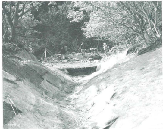
壕跡部作業風景 2
