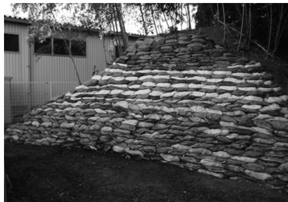
図68 現存土塁保護状況
