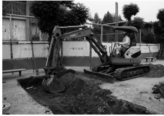
図5 重機掘削
