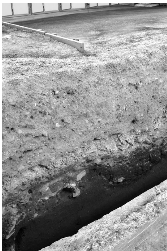
4 2区北西部西壁基壇版築検出状況（南東から）
