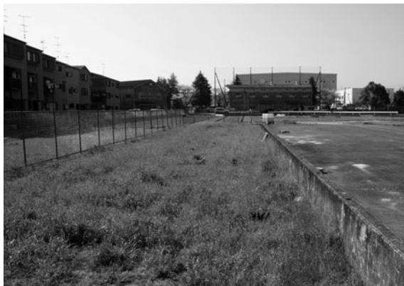
図103 2区調査前全景 (北から)
