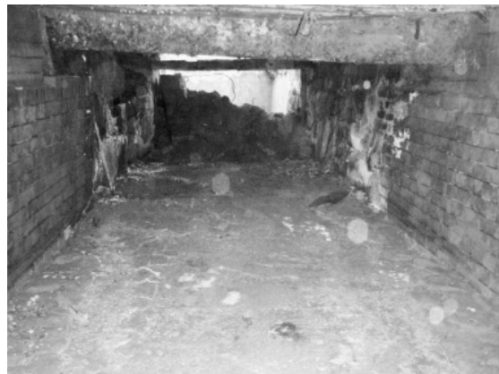
写真8 水路6内部（東から）
