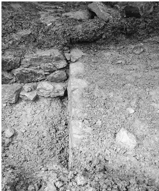
写真16 石垣1・2接合部分（東から）
