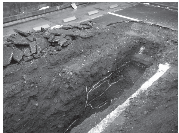
写真 16 調査区西端 溝1検出状況（南東から）
