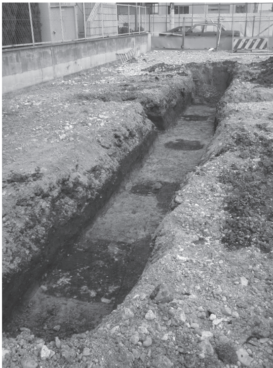
写真 12 4Tr. 全景 (南西から)
