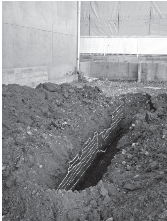
写真14 No.58 地点2 Tr 全景 (南東から)
