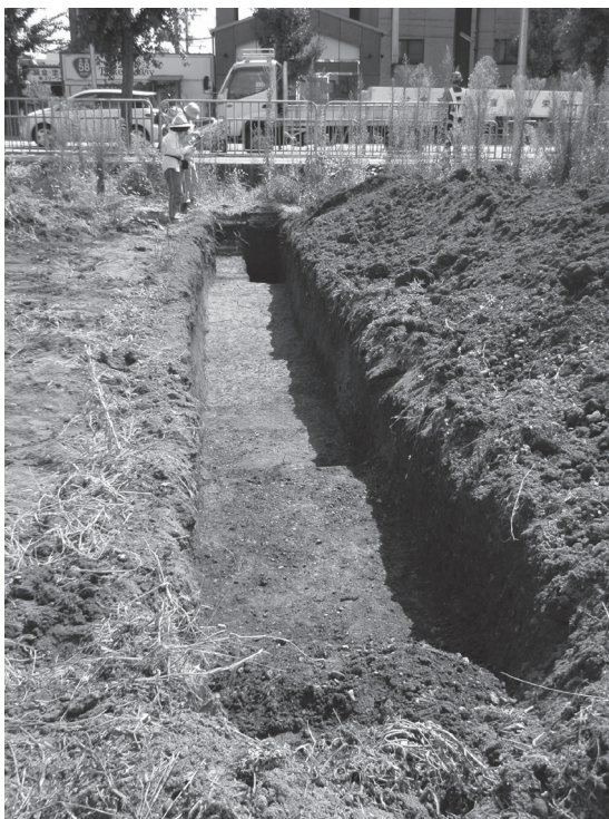
写真 19 トレンチ全景（北から）
