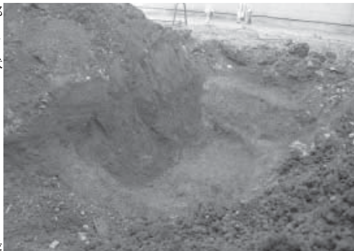
写真6 1 トレンチ全景（南東から）
