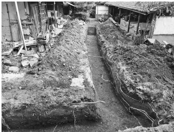
写真 5 東西調査区全景 (西から)
