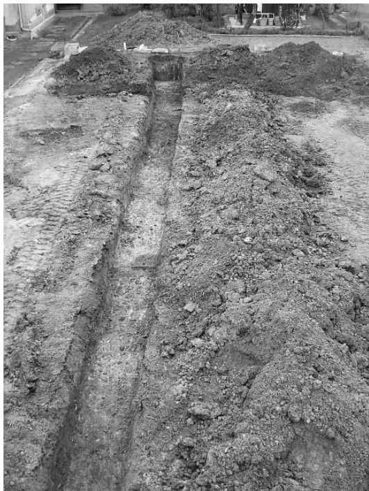
写真2 1トレンチ全景（東から）
