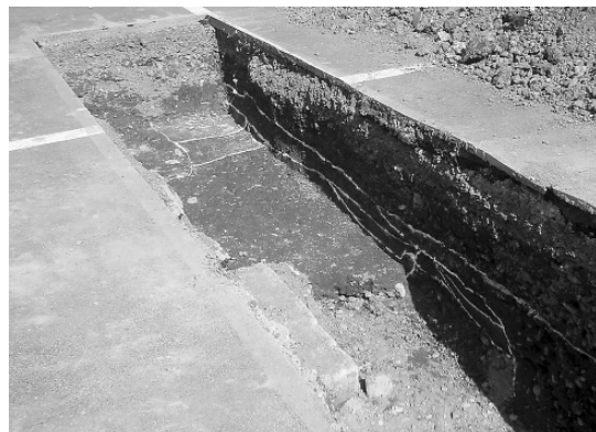
写真7 西鞠負小路東側溝 (北西より)
