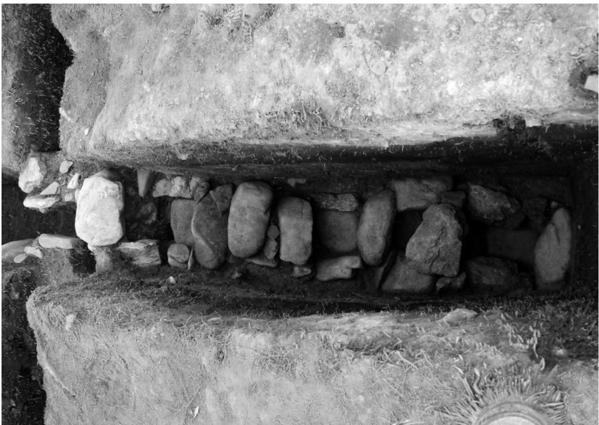
2 排水溝（2・6・9石目の蓋石除去後）
