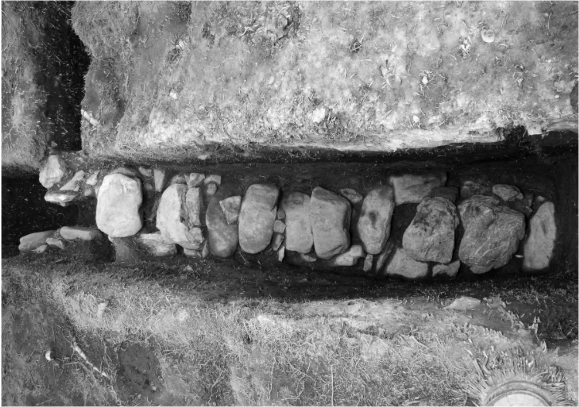
1 排水溝（蓋石除去前）
