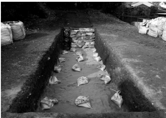
図4 土塁保護および埋め戻し状況（東から）
