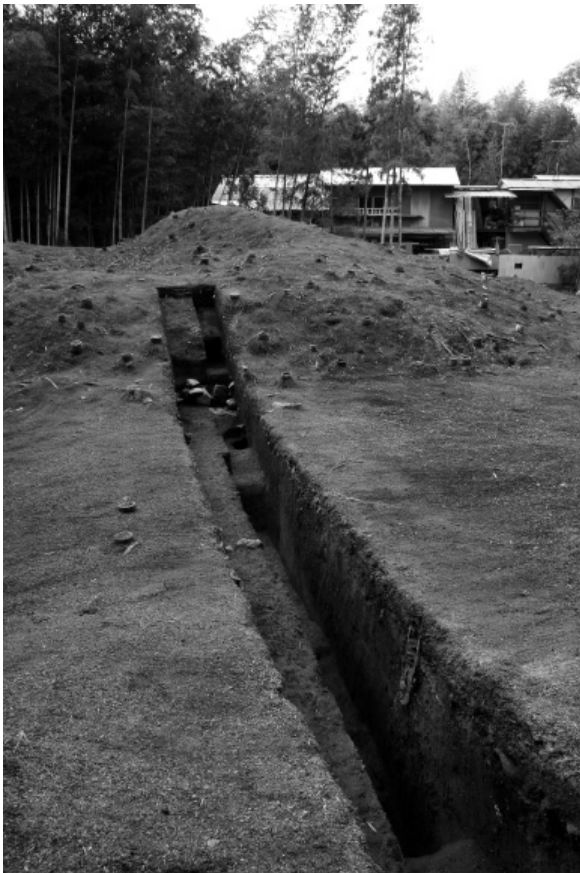
3 3トレンチ (南東から)
