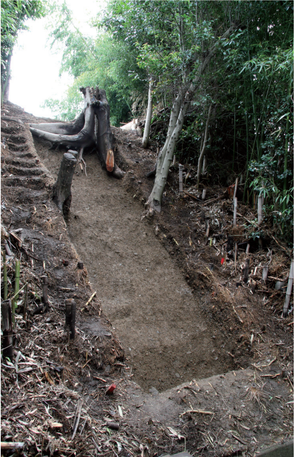
1区南半 土塁(北西から)
