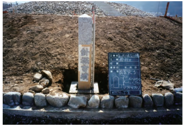
標柱設置状況
