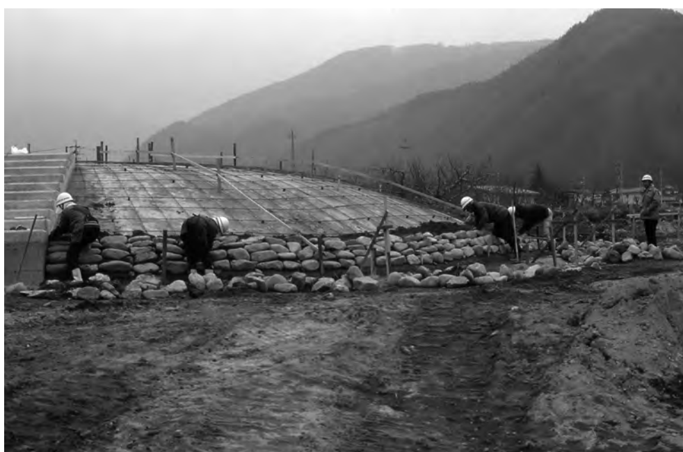
保存整備工事（墳丘石貼作業）
