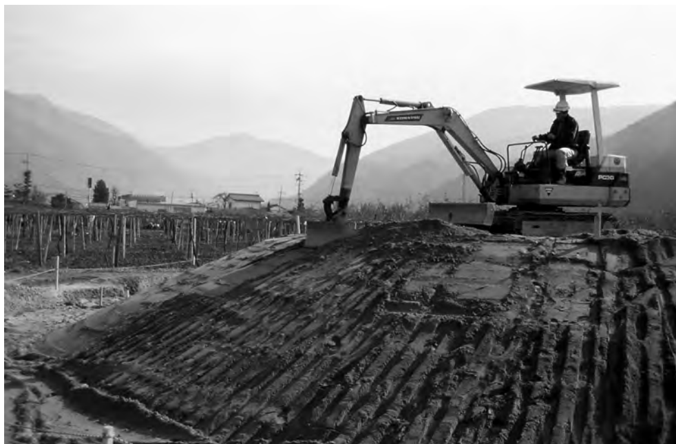
保存整備工事（墳丘覆土作業）
