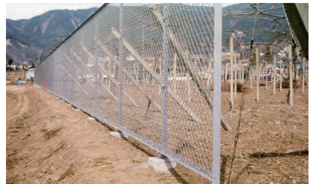
フェンス設置状況
