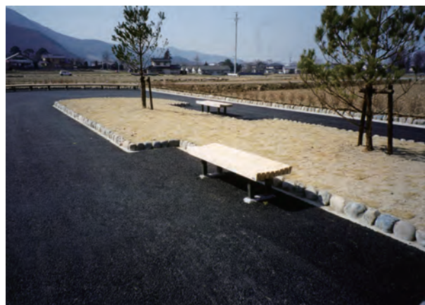
舗装・植栽・縁石・ベンチ設置状況
