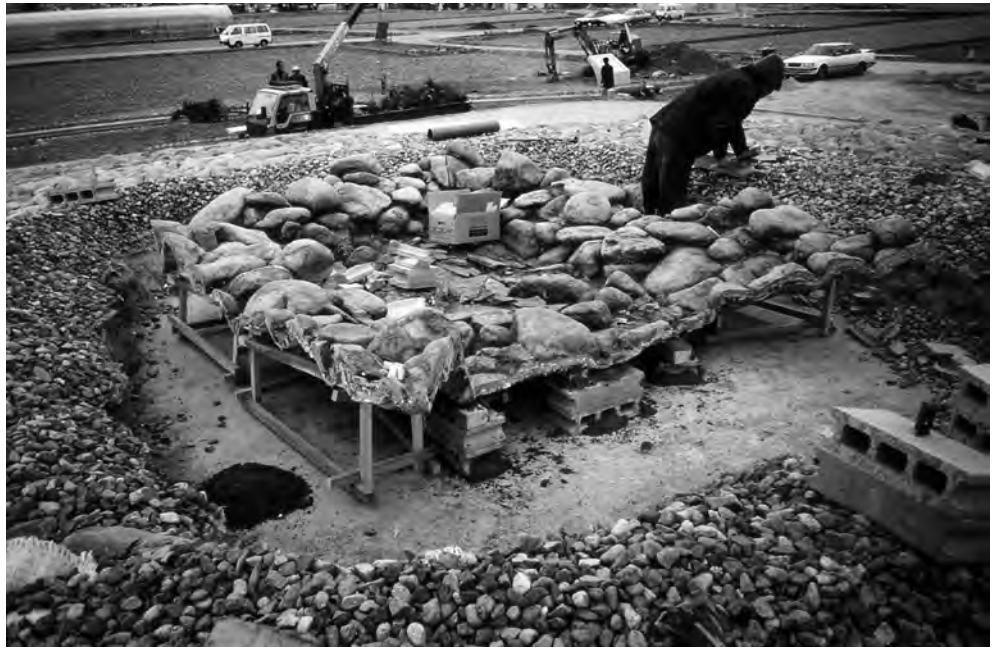
保存整備工事（第1主体復元）
