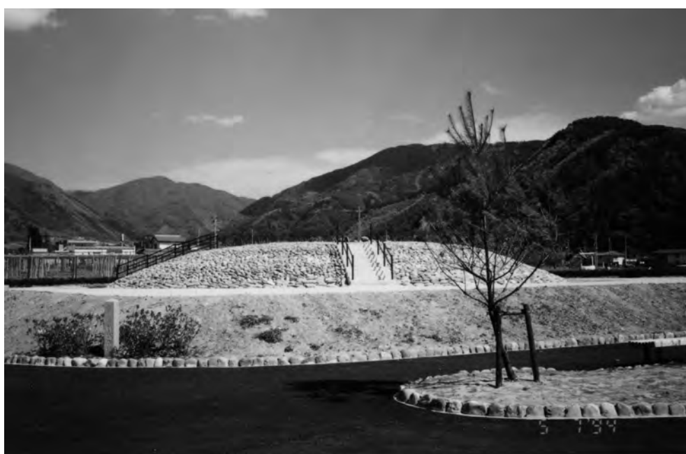
保存整備工事完了状況
