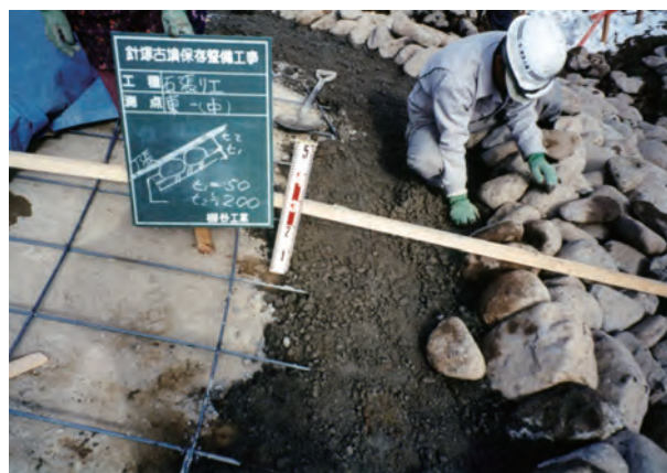
墳丘石貼り状況
