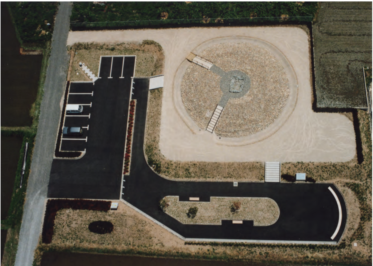
保存復元工事が完了した針塚古墳
