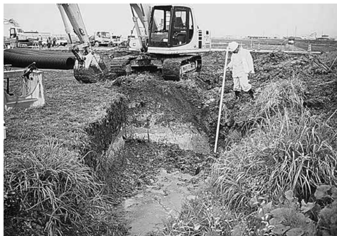
町道工事立会い 東から
