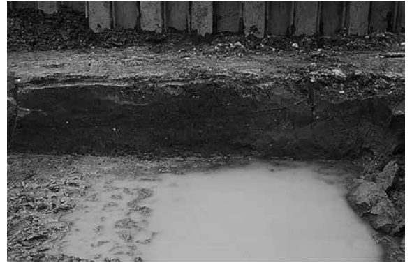
SX21 (28B22グリッド) セクション（西から）
