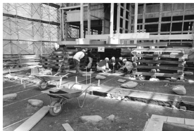
7. 調査風景北棟(南から)
