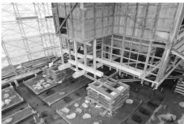
8. 北棟・中央棟調査状況(東から)
